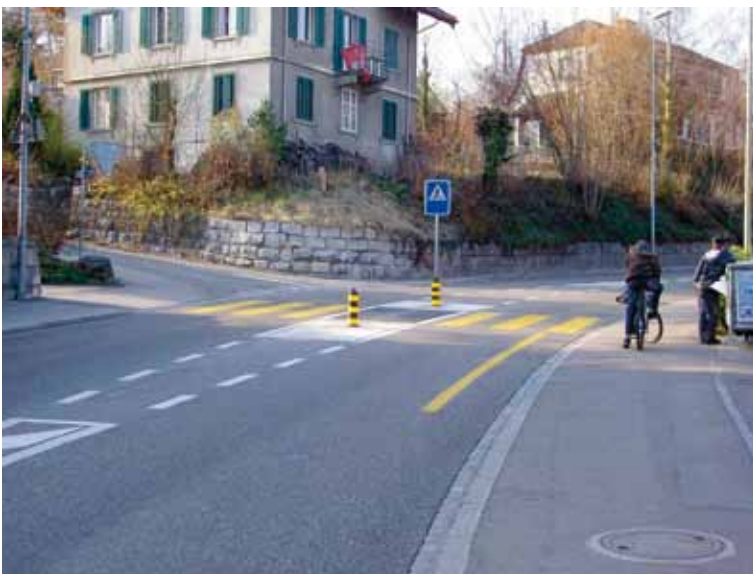
Abbildung 12: Markierte Schutzinseln verbessern die Situation bei Fussgängerstreifen. Noch besser sind gebaute Schutzinseln, da sie noch mehr Sicherheit bieten. (Quelle: Metron Verkehrsplanung AG)
