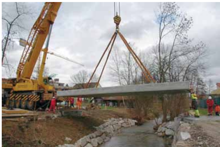
Abbildung 8: Schliessen einer Lücke auf der Veloroute Therwil-Oberwil (Quelle: Romy Heiber, Reinach)
