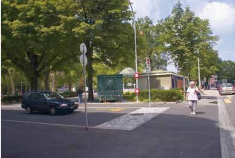
Abbildung 16: Trottoirüberfahrten verbessern die Sicherheit; Beispiel aus dem flächendeckenden Konzept der Stadt Basel. (Quelle: Amt für Mobilität BS)
