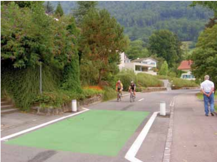
Abbildung 17: Einmündende Fusswege sind beispielsweise mit kostengünstigen farbigen Markierungen, Pfosten und Randlinien besser ersichtlich. Derartige Massnahmen können verhältnismässig rasch umgesetzt werden (Beispiel aus der Gemeinde Weggis LU). (Quelle: Metron Verkehrsplanung AG)
